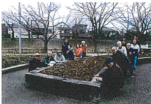
ウッドチップスを敷均して作業完了
