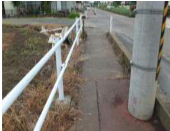
歩道内に電柱があり 通行しにくい
